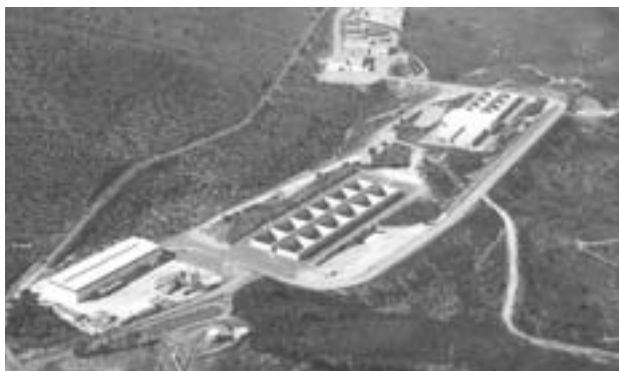
Figura 6. Vista del Centro de Almacenamiento de Residuos de Baja y Media Actividad El Cabril
