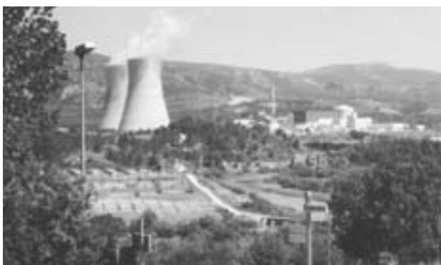
Figura 4. Central Nuclear de Cofrentes
