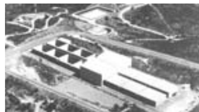
Figura 1. Celdas de almacenamiento de El Cabril
