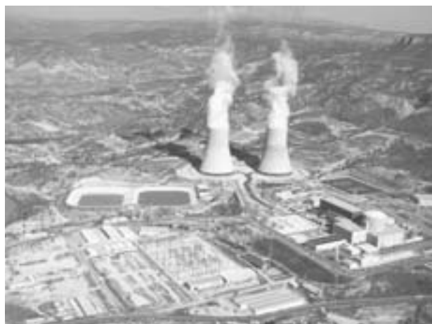
Figura 6. Central Nuclear de Cofrentes
